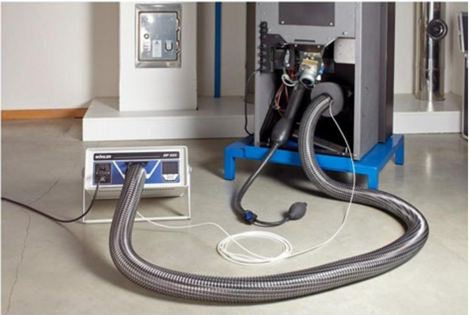
Abb. 62: Aufbau für die Ofendichtheitsprüfung. Anschluss von Luftschlauch mit Abdichtelement am Abgasrohr Feuerstätte sowie Druckanschlusschlauch neben Luftschlauch im Abdichtelement Abgasrohr. Zuluftöffnung an der Feuerstätte mit Abdichtblase oder Abdichtelement abdichten.
