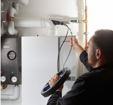
Abb. 13: Positionieren der oberen Abdichtblase mit Teleskopset und Haspel.
