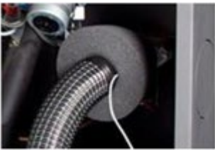
Abb. 64: Anschluss an das Abgasrohr der Feuerstätte
