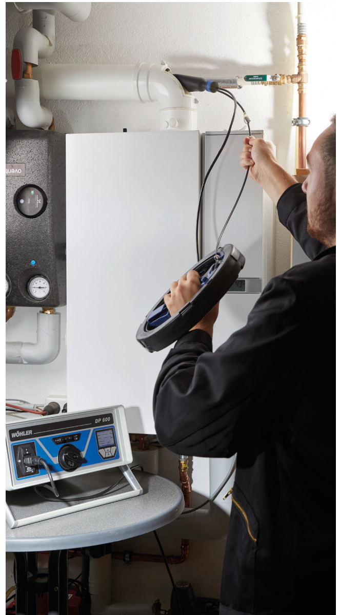
Prüfung von Abgasleitungen Typ P im Überdruckbetrieb bei 200 Pa. Grafische Ergebnisdarstellung, auch ausdrückbar.
