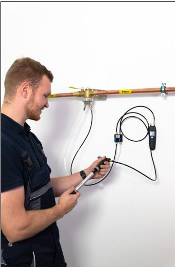
Abb. 9: Anschlussarmaturen zum Aufpumpen über eine Luftpumpe
