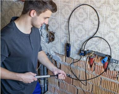
Abb. 33: Aufpumpen der Wasserleitung mit Luft, Dichtheitsprüfarmatur über Hochdruckstufenstopfen an Wasserleitung angeschlossen
