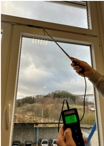
Fig. 27: Détection de fuites sur le cadre de la fenêtre
