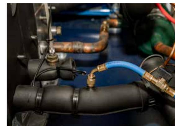
Tuyaux de raccordement avec vannes à bille pour une fermeture et une ouverture rapides du flux de fluide frigorigène.
