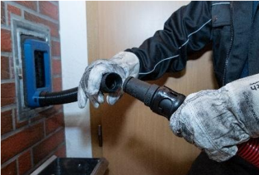
Abb. 5: Staubsauger an Schlauchadapter anschließen
