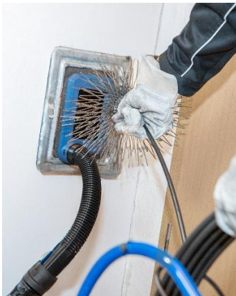
Abb. 8: Reinigungswerkzeug durch das Wöhler SweepGate in die Abgasanlage einführen
