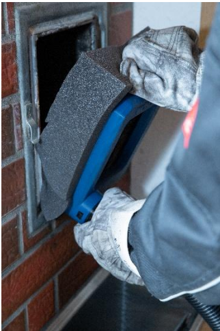
Abb. 4: Einsetzen des Wöhler SweepGates mitsamt Abdichtelement und Schlauchadapter
